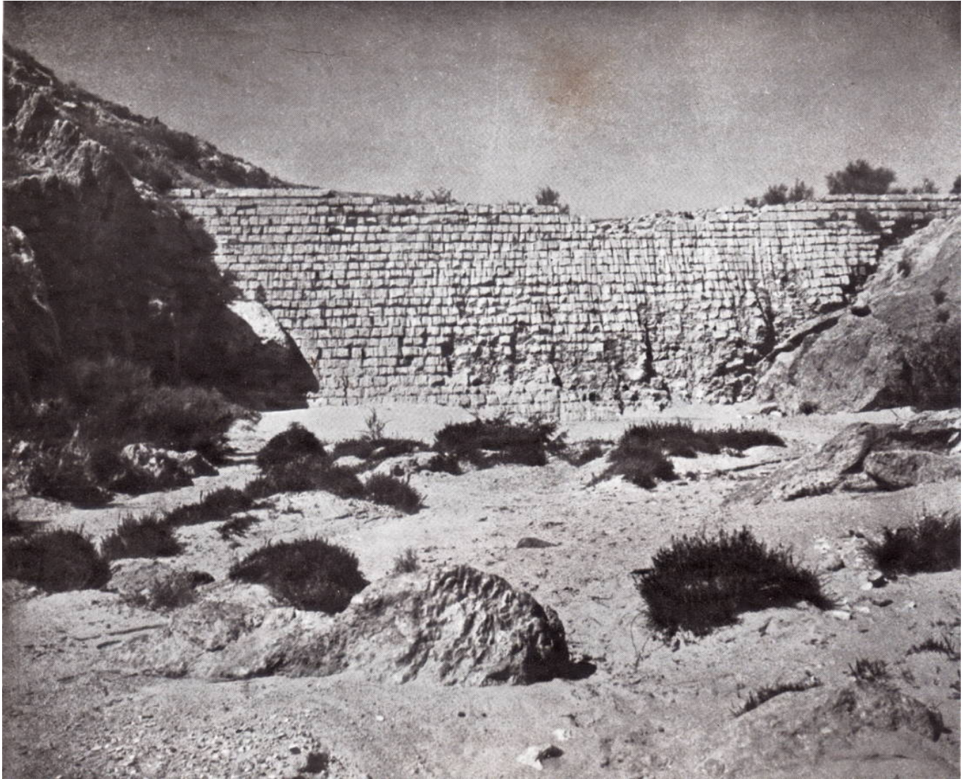
איור 4 - סכר ביזאנטי בנחל ממשית. מקור: רייפנברג 1950 "מלחמת המזרע והשימון".
